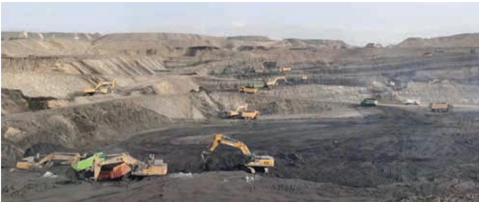
施工团队进行挖土及拨离工作
